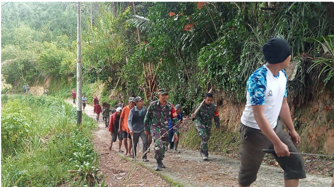
Di lokasi itu, Babinsa dan warga terlihat bersinergi membersihkan setiap area saluran irigasi yang berada di Dusun Rante Dambu. Tujuannya, ialah untuk memperlancar pengairan ke sawah warga.
